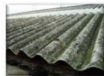
Toitures en plaques ondulées
