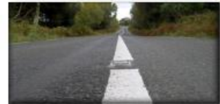
Revêtement bitume, enrobé
